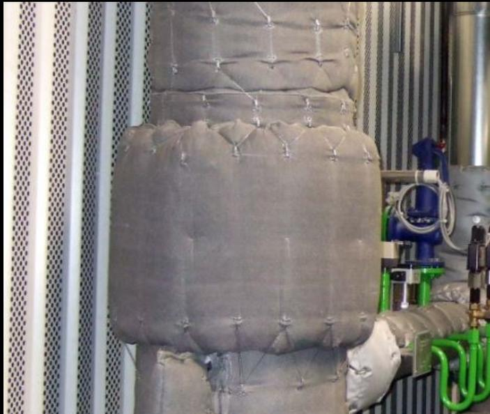
**BHKW Zubehör:** Zum Beispiel die **Flansch Isolierung** bzw. Flange Isolierung. Wie führen jede erdenkliche Art und Form von textilen Isolierungen für Abgasführende Bauteile eines BHKW's.
